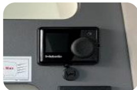
Régulateur de chauffage
